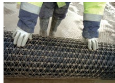
Los tamanos estándar de los rollos hacen que la manipulación de la geomalla TriAx sea sencilla y se genere una cantidad mínima de desperdicios.
